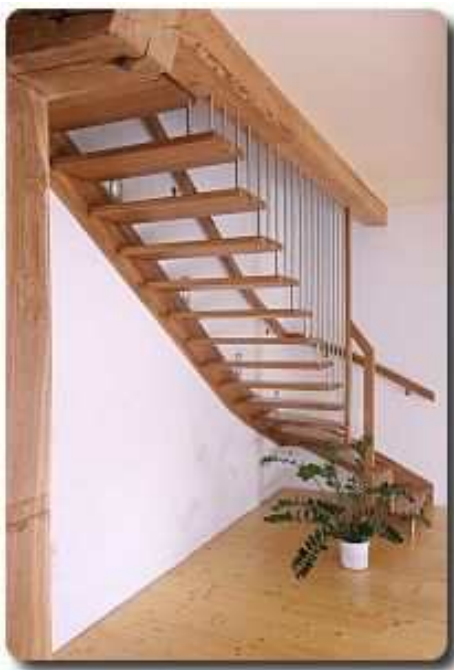
Obr. č. 12 Zavěšené schodiště, stupně na jedné straně vsazené do schodnice, na druhé straně zavěšené [9]
