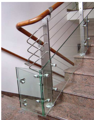
Obr. č. 8 Ocelové zábradlí kombinované se sklem, dřevěné madlo [6]
