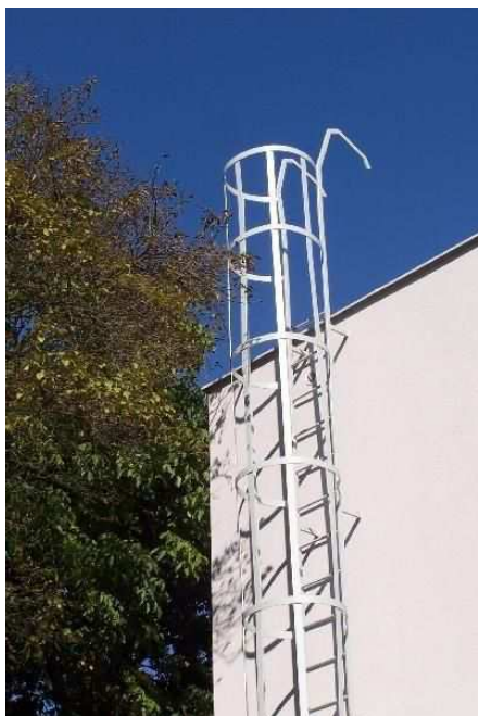
Obr. č. 14 Ocelový žebřík s bezpečnostním košem [11]
