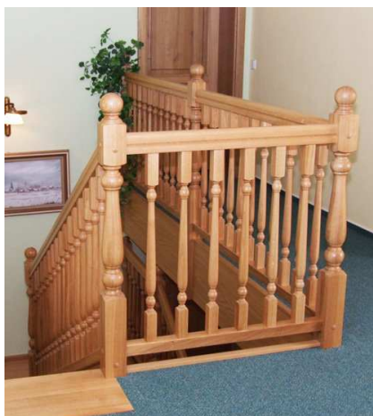
Obr. č. 7 Celodřevěné schodiště i zábradlí [5]
