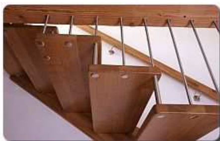
Obr. č. 11 Detail zavěšeného schodiště [9]
